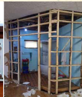
Umbau des Bades
